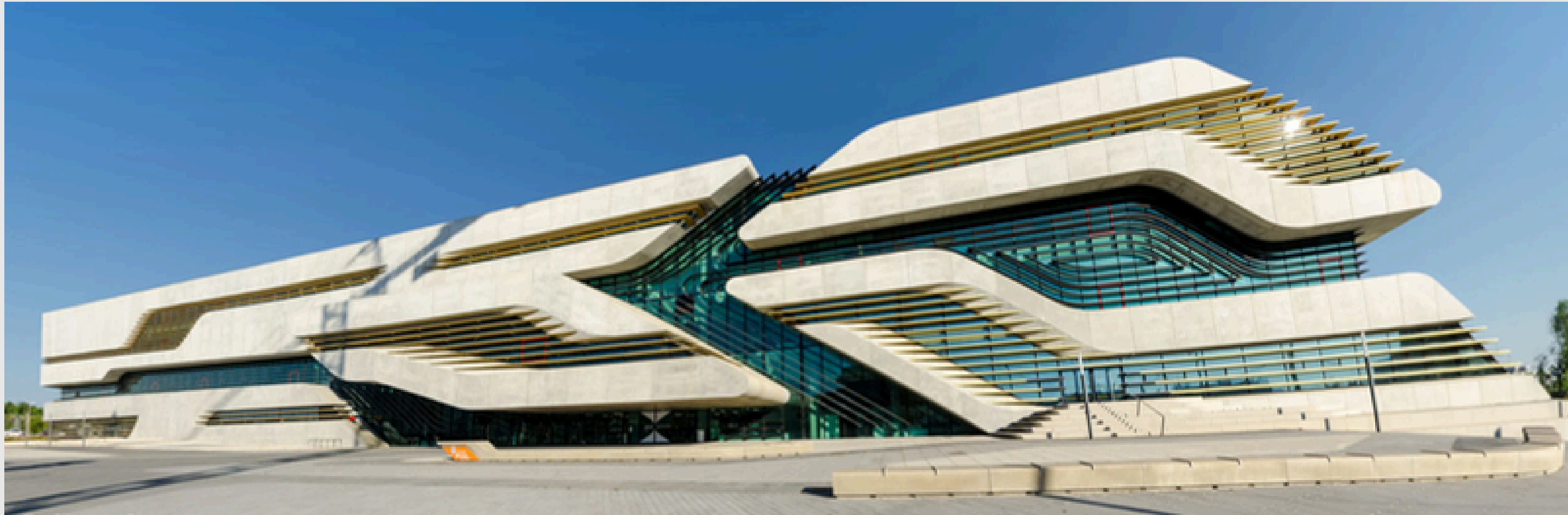
SHOOTING ARCHITECTURE: Archives départementales de l'Hérault - Pierre VIVES à Montpellier — Clément COUSIN
